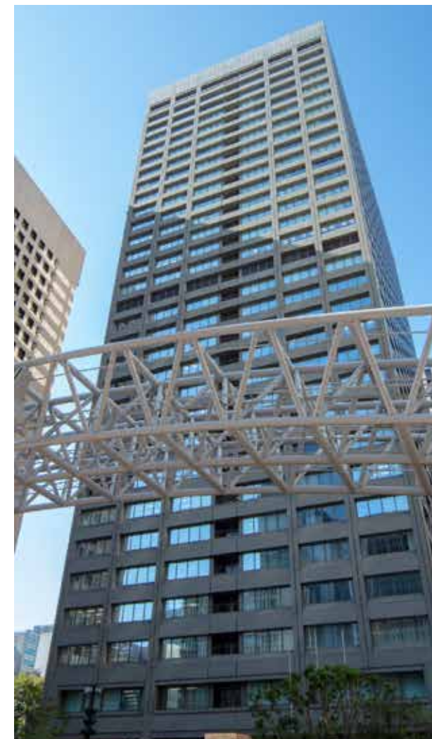
本社 日比谷国際ビル 外観
