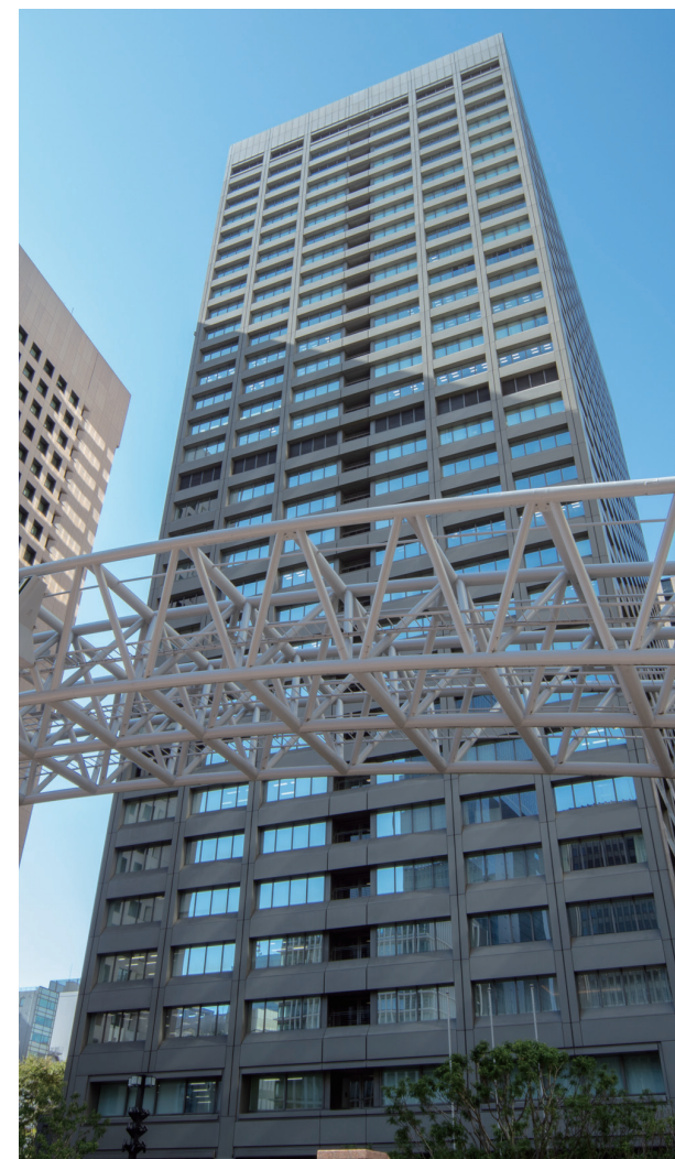
本社 日比谷国際ビル 外観
