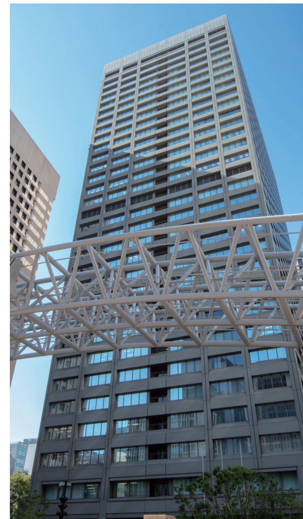
本社 日比谷国際ビル 外観
