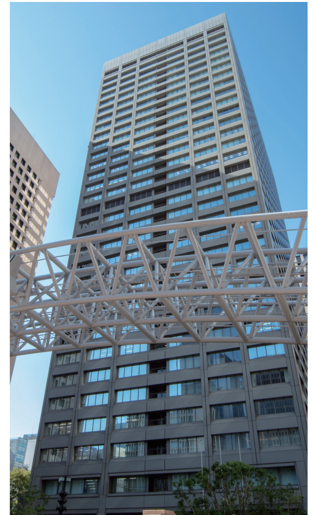
本社 日比谷国際ビル 外観
